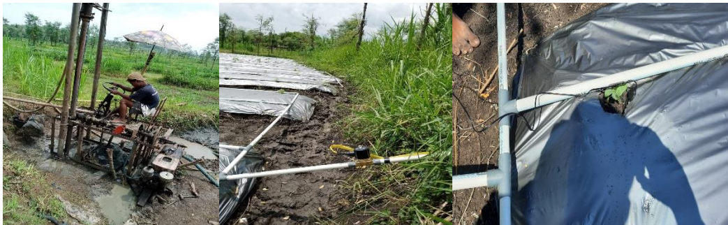
Gambar 1. Pembuatan sumur bor dan Instalasi Pipa irigasi tets pada bedeng serta pangkal tanaman cabai
